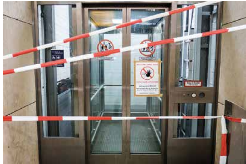
Die Internetseite brokenlifts.org informiert fast in Echtzeit über Defekte bei Aufzügen
